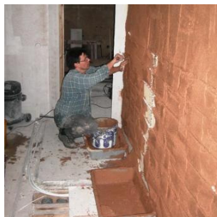
Bau einer Lehm-Heizwand
