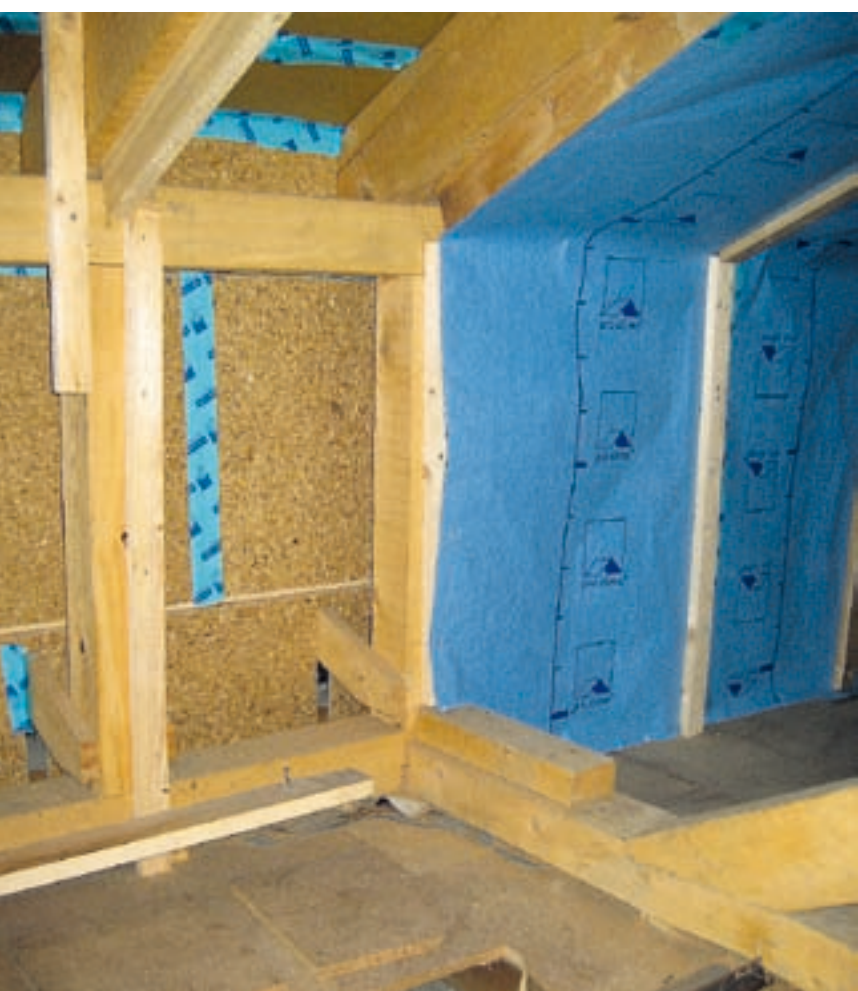
Bei den bestehenden Holzelementen am Boden werden die Hohlräume am Rand mit Zellulose ausgeblasen. Darauf kommt eine Zusatzdämmschicht auf den Boden, oder es wird im Schrägdachbereich mit 28 cm Zellulose ausgeblasen.
